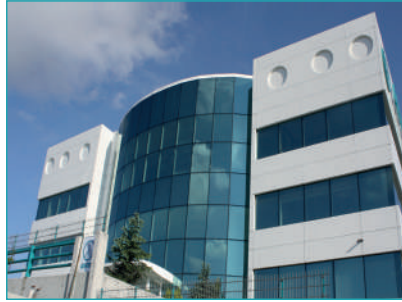
Arfen İnşaat A.Ş. / İSTANBUL
